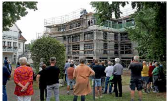
Richtfest am neuen Erweiterungsgebäude des Elisabethenheims in Müllheim
